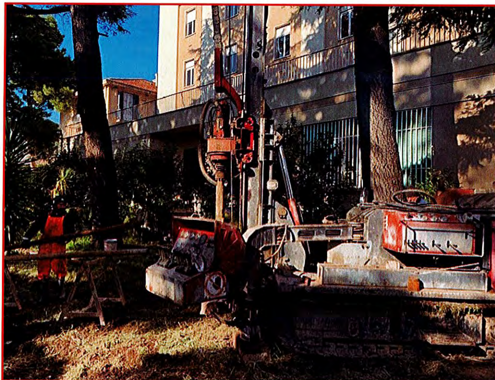
Fig. 6.16 Fase esecutiva sondaggio a carotaggio continuo S/2
