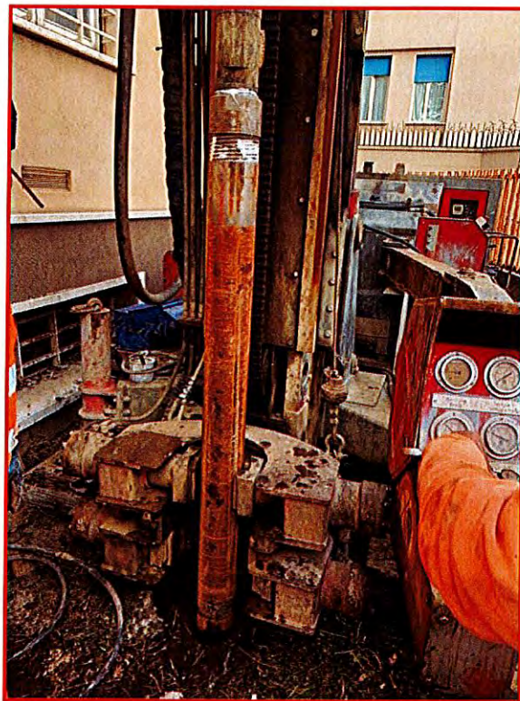
Fig. 6.12 Installazione dei rivestimenti metallici provvisori del sondaggio S1
