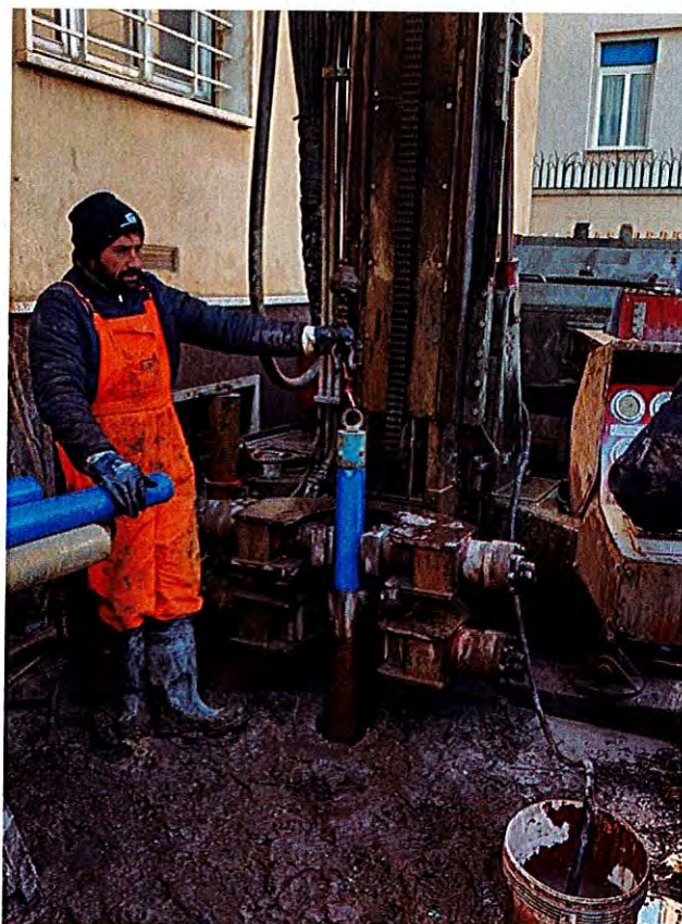
Fig. 6.14 Installazione piezometro a tubo aperto nel sondaggio S1
