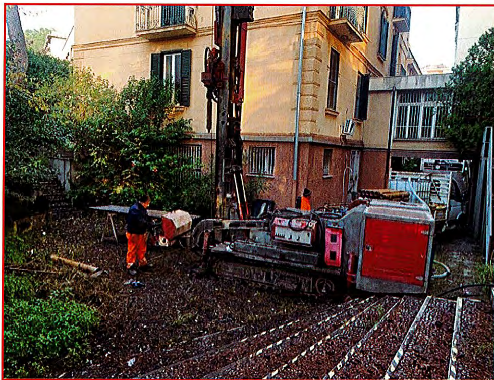
Fig. 6.29 Fase esecutiva sondaggio a carotaggio continuo S/3
