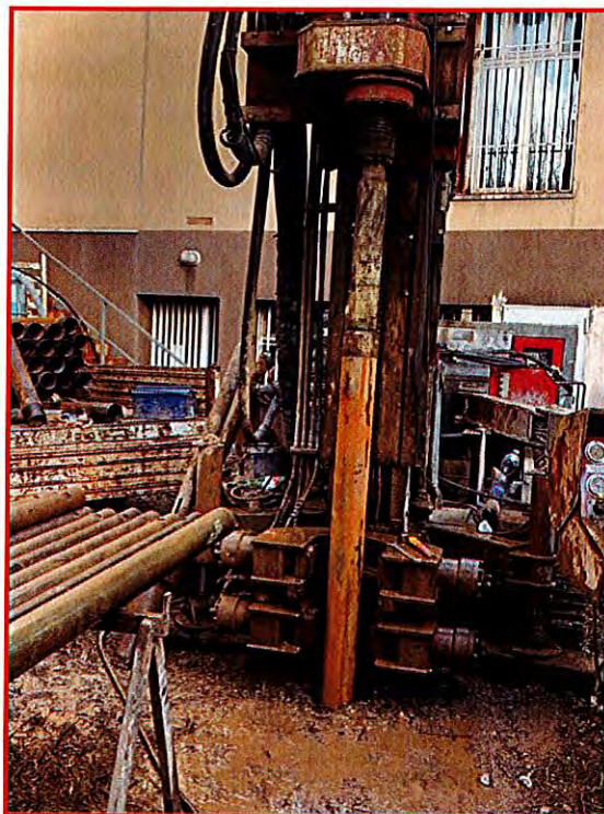
Fig. 6.39 Installazione dei rivestimenti metallici provvisori del sondaggio S/3
