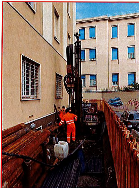
Fig. 6.2 Fase esecutiva sondaggio a carotaggio continuo SI
