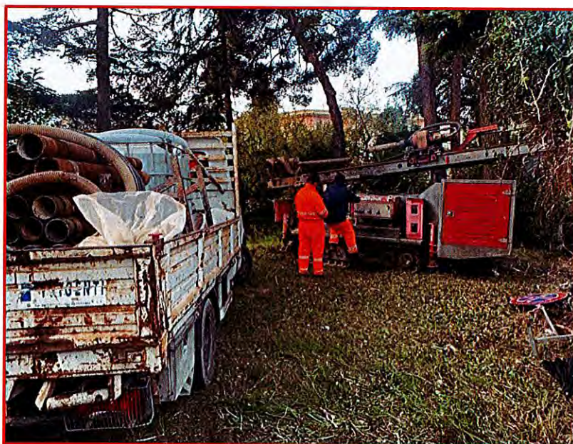
Fig.6.1 Fase di scarico delle attrezzature per il sondaggio S1
