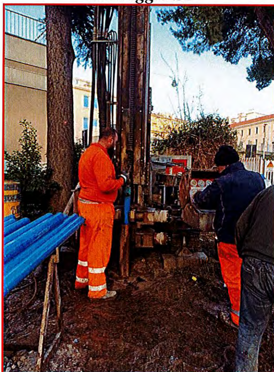
Fig. 6.27 Installazione piezometro a tubo aperto nel sondaggio S2
